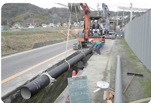
▲ 水道管耐震化工事の様子
