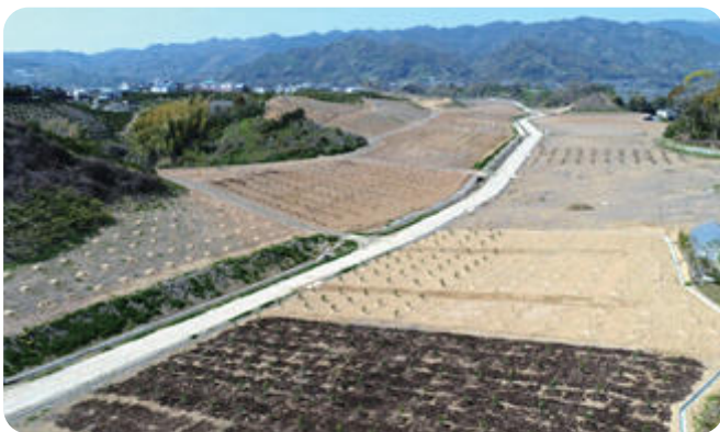
▲ ほ場整備 (下丹生谷地区)
