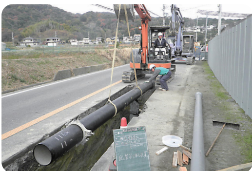
▲ 水道管耐震化工事の様子
