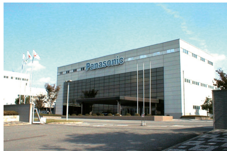
和歌山工場外観
