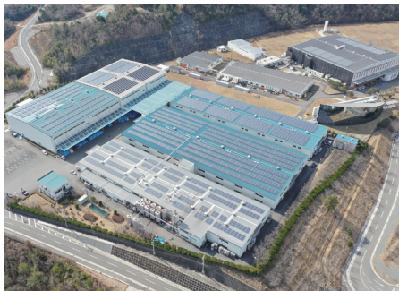
和歌山工場全景
