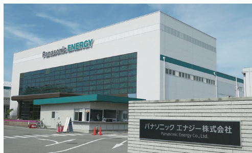
和歌山工場外観
