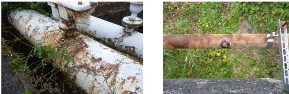
図 4-9 老朽化した管路
