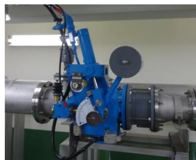
図 6-4 緊急遮断弁
