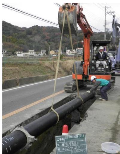
図 6-3 耐震管工事の様子
